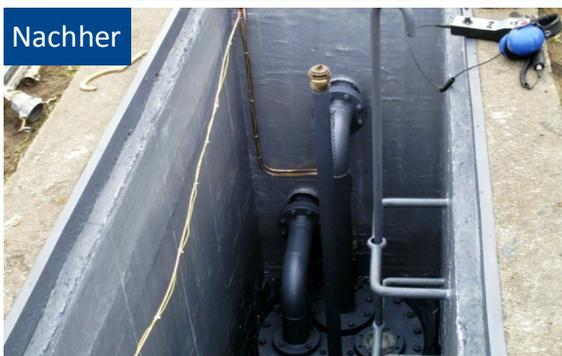
Mit einen speziell entwickelten und zertifizierten Beschichtungsaufbau werden Boden und Wände des Domschachts so abgedichtet, dass einerseits die notwendige Elastizität des Systems und andererseits die chemische Beständigkeit gegen Kohlenwasserstoffe gegeben ist.
